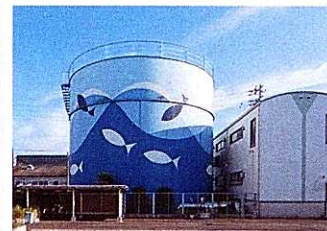
団地内の工場が使う水のタンク
