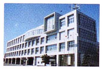
焼津市消防防災センター
