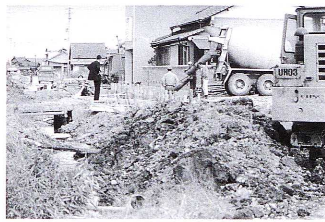
③ 焼津駅周辺区画整理の様子
