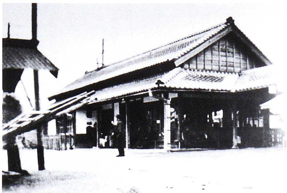
③東海道線（当時は東海道鉄道と呼称）焼津駅舎
