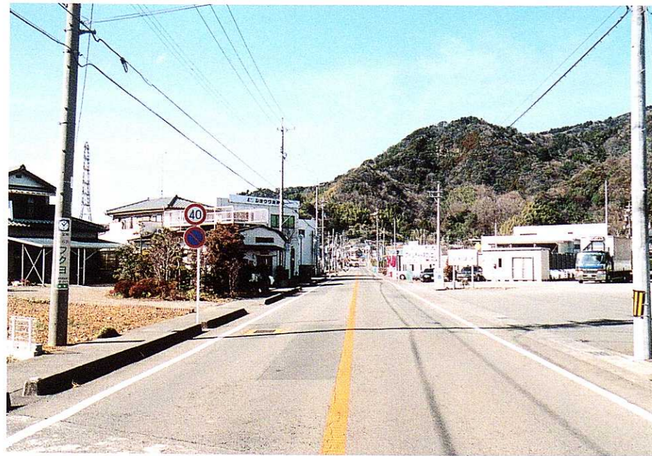
③岡部街道 大正期、県道の拡張工事が各地で活発に行われた。ここ県道焼津岡部線でも数次にわたり拡張工事が行われた。
