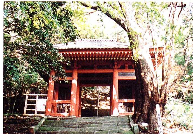
⑧香集寺の仁王門（市指定） 建立年代ははっきりしないが江戸時代末期に著わされた『駿國雜志』中の「當日山之圖」には、入母屋造の「二王門」と記されていることから現在の門はそれ以降に改修または再建されたものであろう。（焼津市浜当日）
