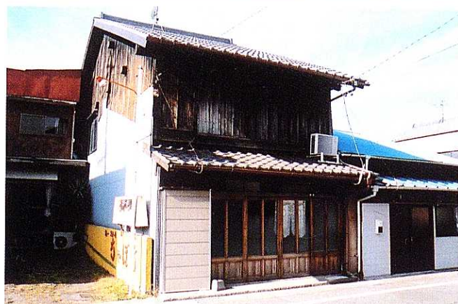
⑤吉井家住宅 駿河湾に面した海岸通りにあり贅飾製造を営んでいた吉井家住宅は、間口が狭く奥行の長い敷地に片方を通り土間、反対側に居室を縦列させたいわゆる町家建築。切妻造棧瓦葺、2階との連絡は箱階段を利用。(焼津市城之腰)
