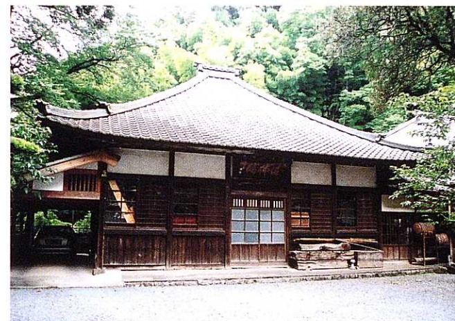
④林叟院の禪堂 1728年（享保13）の再建といわれ、寛政3年の境内絵図には5間四方、高さ1丈2尺茅葺の僧堂として記されている。堂内正面に文殊菩薩像を祀る。正面入口虹梁上に「選佛場」の額を掲げる。（焼津市坂本）
