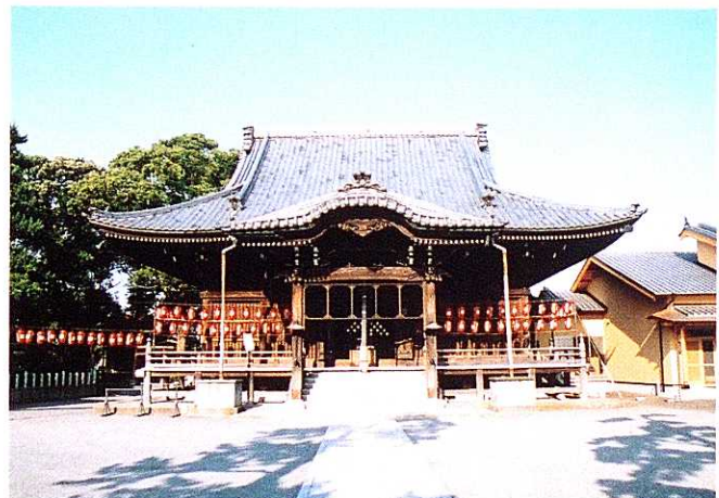
⑩海蔵寺の本堂 現存の本堂は安政の地震直後の1860年（万延元）に建てられたものと伝えられる。紀州徳川家の掃依篤く、正面の両折棧唐戸には葵紋を刻む。軒は尾垂木を出し、二手先斗拱を組む。（焼津市東小川）
