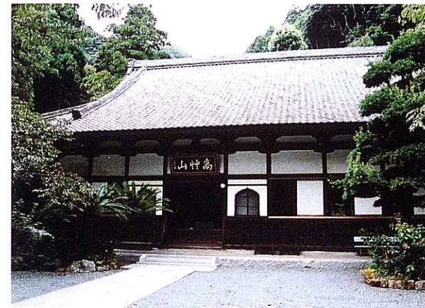
②林叟院の本堂 1808年（文化5）の再建と伝えられる8間取りの本堂で、元は茅葺であったが1957年（昭和32）瓦葺に改められた。正面大縁の上間部分がかつては庫裡および禪堂に通じていた。（焼津市坂本）
