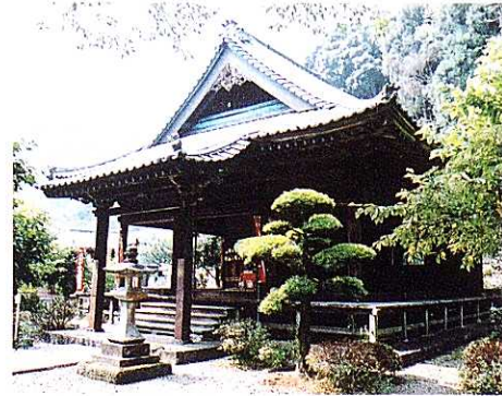
⑦法華寺の本堂 元は茅葺であったが1905年（明治38）に瓦葺に変更されるにつき小屋組も改変、建立時期を示すものは無いと思われたが、貫材の一部に墨書が見つかり、1695年（元禄8）に建てられたものであることが判明した。（焼津市花沢）
