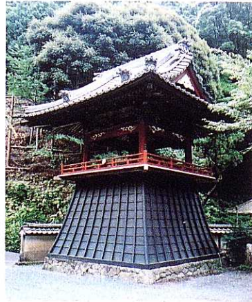
⑤林叟院の鐘楼（市指定） 1844年（天保15）、26世祖海徹宗師代、藤枝白子町の大工棟梁桑原清七郎らの手により再建された袴腰付鐘楼。棟札には施主越後島村甲賀伊兵衛、世話人下大覚寺村伊東清次郎ら4名が名を連ねる。（焼津市坂本）
