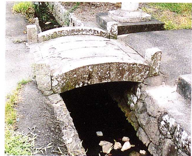
⑧若宮八幡宮の石橋（市指定） 1835年（天保6）6月、関方村の石工五左衛門によって架けられたもので、四隅の柱側面に架橋にかかわった人々の名を刻む。(焼津市中里)
