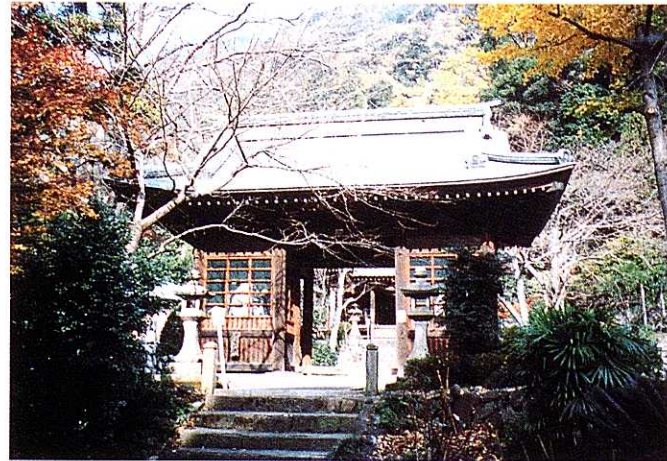
⑨法華寺の仁王門（市指定） 1703年（元禄16）再建と伝えられる入母屋造銅板葺八脚門。元は茅葺であったといわれるが現状の姿になった時期は不詳。柱頭大斗上枅肘木には不自然な埋木もあり、改変の跡がみられる。（焼津市花沢）
