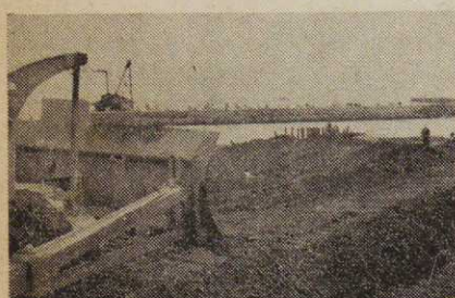
(第二漁船渠の工事は目下進められています)
