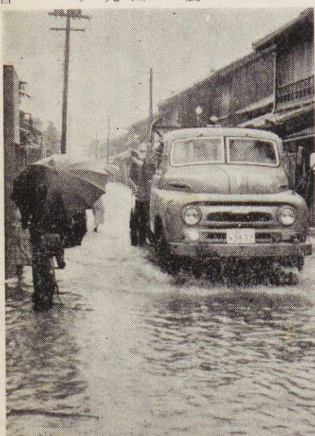
(写真・川が氾らんして街々にも水が流れ出した)
