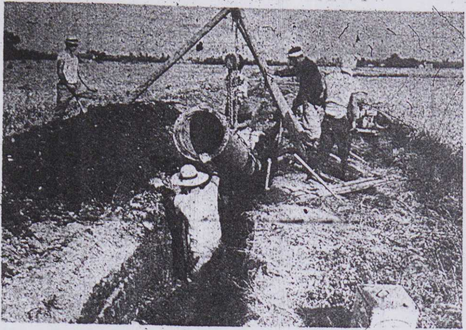
この二つの工事を進めている間は、配水管内に流れている水の経路が変ったり、水の流れる速さが変わったり、象により、管内にあるサビ物などが浮き、あるいは沈殿物などが、各所に一時たまり、にごりがあるものと考へられます。
