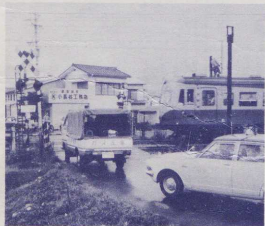
これまでは、普通車がすれ違いのにっぱいの踏切でしたが、11月からは大型車もすれ違えます。
