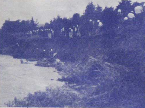
昨年の大雨のとき、朝比奈川の水量がふえ、越後島地区の堤防が決壊寸前となった。
