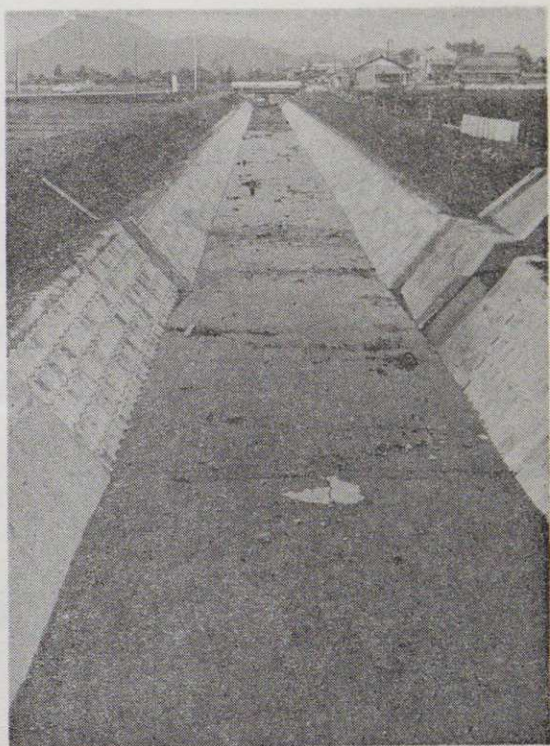
写真 最近出来上がったばかりの北部幹線排水路。 坂本地区
