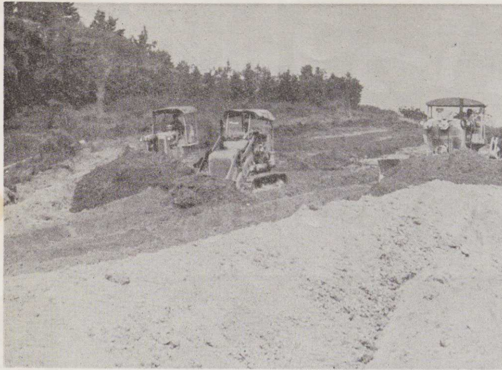
第1期工事が始まり、山は削られる。ことし中にはこの造成工事も完了する。
