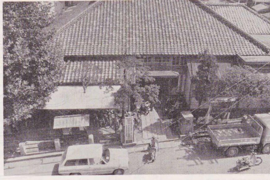
まもなく姿を消す現在の庁舎
