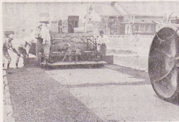
道路舗装には特に重点がおかれた。 (写真は五ヶ堀之内三ヶ名線の舗装工事)
