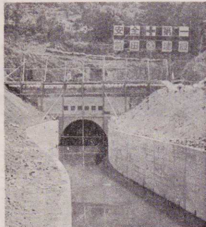
【完成した石脇隧道の西側入口】
