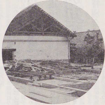
旧校舎は解体される
