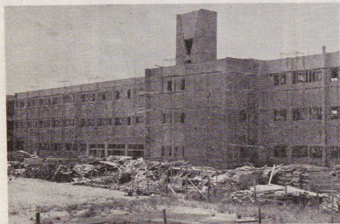
九月中旬に完成する 予定の東益津小学校
